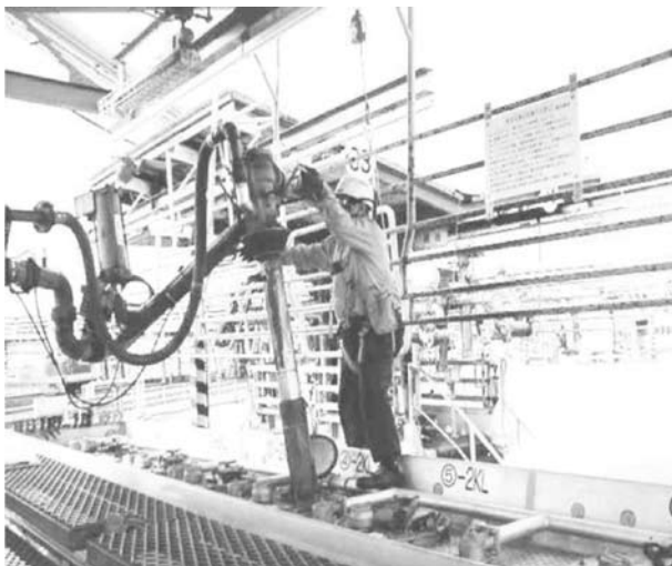
図 補-28. タンクローリーへのガソリン積み込み作業（屋外）
